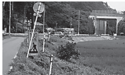
県道相馬浪江線の未整備区間
