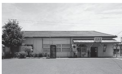
現在の鹿島駅舎
