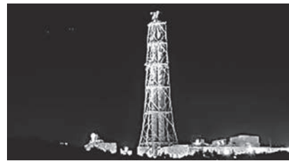
ふくしまイエローグリーン ライトアップ（原町火力発電所）
