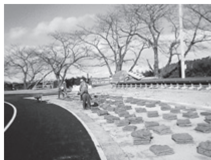
改修が進む陸上競技場
