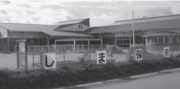
木造で建築された鹿島保育園（平成18年築）
