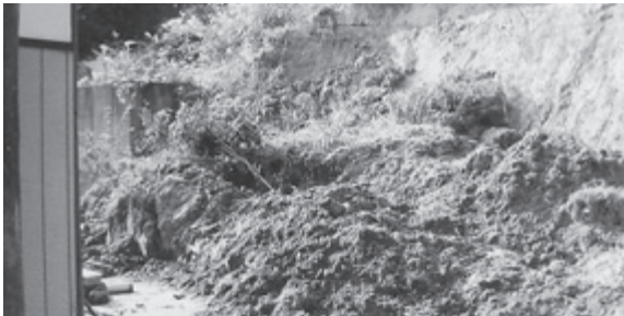
土砂崩れ現場（原町区）
