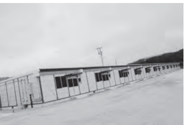
仮設事務所 (原町区信田沢)
