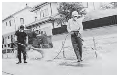
除染作業（原町区北町2地区）
