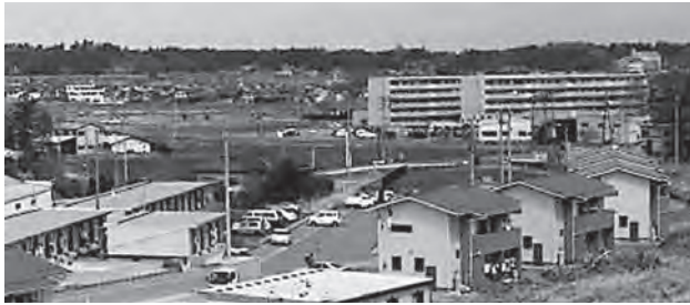
鹿島区寺内地内の仮設住宅・市営住宅
