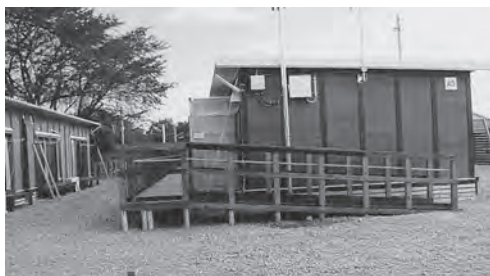
高見町第1仮設住宅（原町区）
