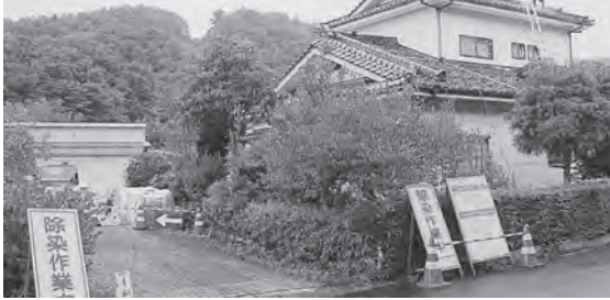
片倉地区除染状況
