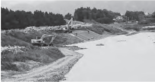
新田川護岸工事（鮭川橋付近）
