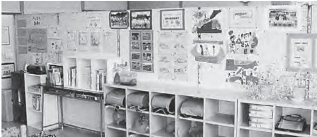
福浦小学校の間仕切り
