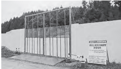
10月3日 押釜地区仮置場設置
