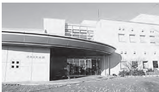
被災した浮舟文化会館
