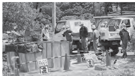
除染作業の様子（原町区押釜）
