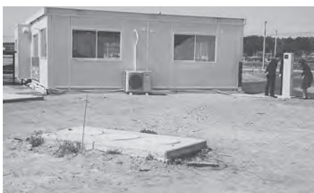
撤去されない浄化槽（原町区泉）
