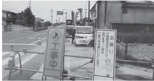
下水道復旧工事（小高区）
