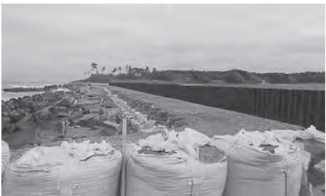
仮復旧後した海岸堤防（鹿島区北海老）
