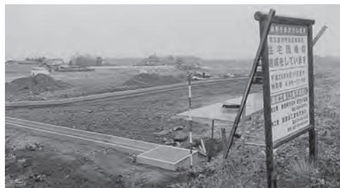
上高平住宅団地造成地（原町区）
