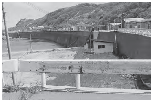
北海道奥尻町の防潮堤
