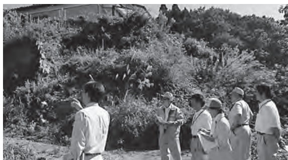
がけ崩れ現場の視察(小高区吉名)
