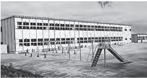
小高4小学校仮設校舎（鹿島中グラウンド内）
