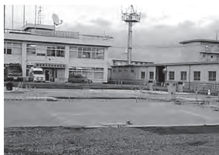
消防・防災センター建設工事
