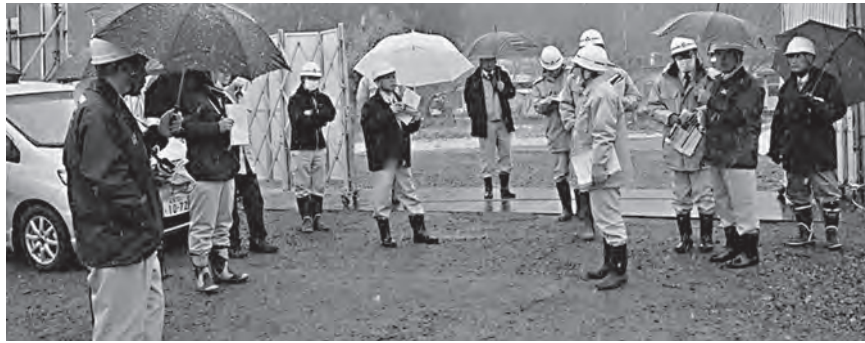
一時保管場を完了し水田へ再生工事中（原町区大原）
