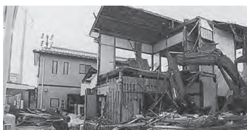
解体が進む罹災住宅（小高区）
