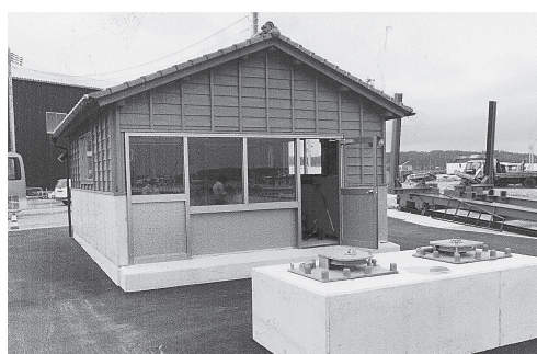
真野川漁港の漁船修繕施設（鹿島区）
