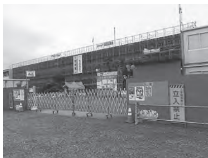
石神第二小学校耐震工事(原町区)
