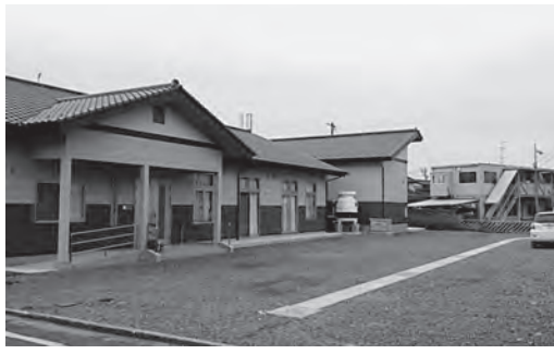
大町地域交流センター バイオマス発電設備
