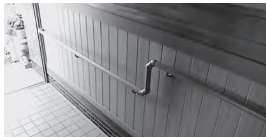
補助で設置した手すり（原町区）
