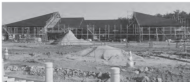
建設中のセデッテかしま
