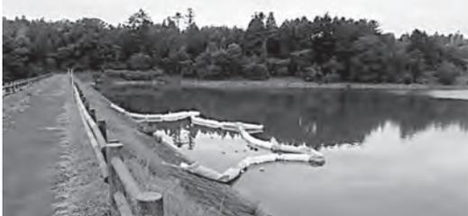
シルトフェンスによる流出抑制・拡散防止対策 (広野町、西の沢ため池)
