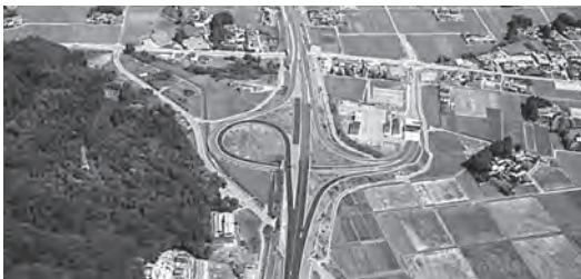
上空から見た南相馬インターチェンジの様子
