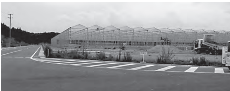
誘致企業の施設建設が進む下太田工業団地
