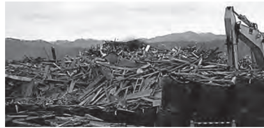
解体の仮置場
