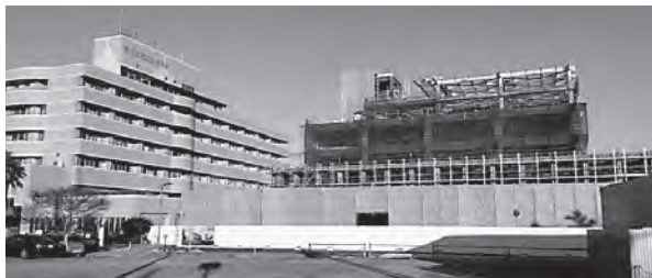
建設が進む脳卒中センター（平成 27 年 12 月）
