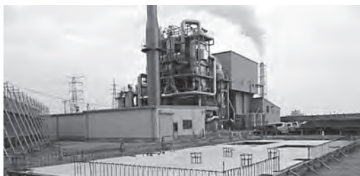
建設中の有害鳥獣焼却炉 (相馬市)
