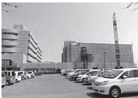
建設中の脳卒中センター（3月30日撮影）
