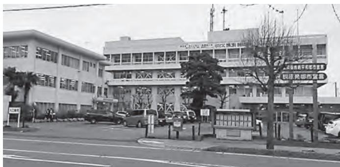
新庁舎建設が予定される老朽化した南相馬市役所
