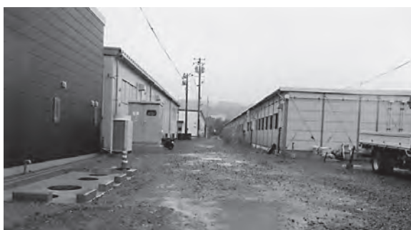
今後譲渡される仮設施設（信田沢工業団地）
