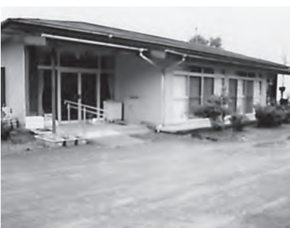
無償譲渡される鹿島区ことぶき荘
