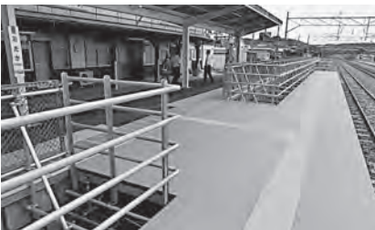
小高駅折返しのための仮設ホーム
