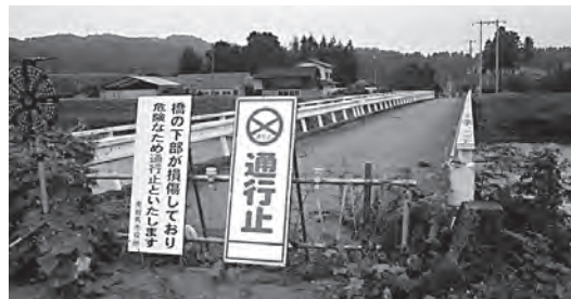
復旧が待たれる かづか 庚塚橋
