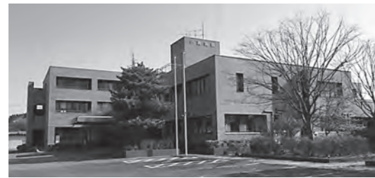
解体が進まない小高病院
