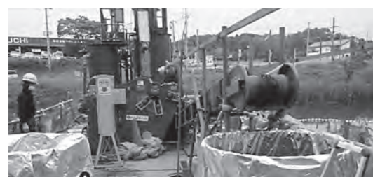
ため池除染の様子(原町区)
