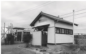
改築される磐城太田駅前公衆トイレ
