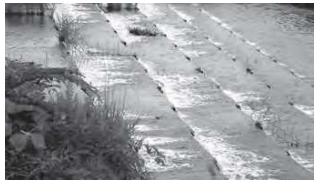
改修まれたる栢木堰
