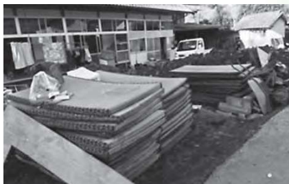
床上浸水被害の住宅（鹿島区上栃窪）
