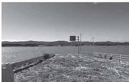
原町区泉の水田 60ha 冠水
