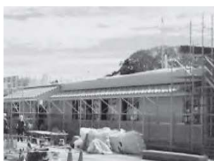
建設中の小高認定こども園
