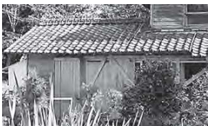
荒廃の進む空き家
