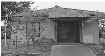
角川原総合研修センター
