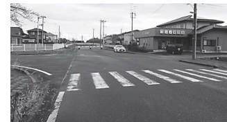
あさひ地区の床上浸水
