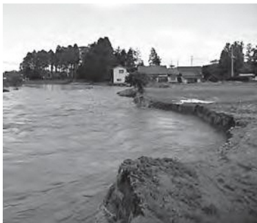
令和元年東日本台風の被害状況
