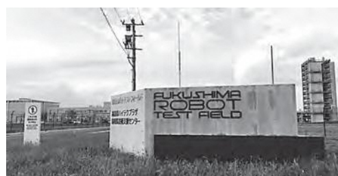
今後の利活用が期待される福島ロボットテストフィールド
