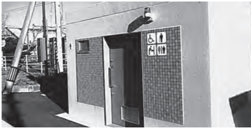
洋式化されたトイレ (磐城太田駅)
